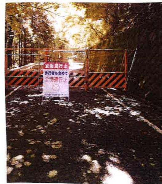
バリケード（立石建設側）
